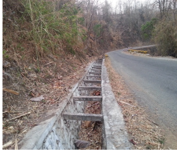
ကောင်းမွန်စနစ်ကျသော ရေထိန်းသိမ်းမှုစနစ်ရှိသည့် ကျောက်ခင်းလင်း (ကျောက်ထု - မင်းတပ် ကားလမ်း)
